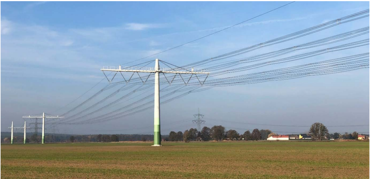
Bild 1 Versuchsanlage der „Raumoptimierten Freileitung“ (CompactLine) in Jessen mit konventionellen 380-kV-Freileitungen im Hintergrund
