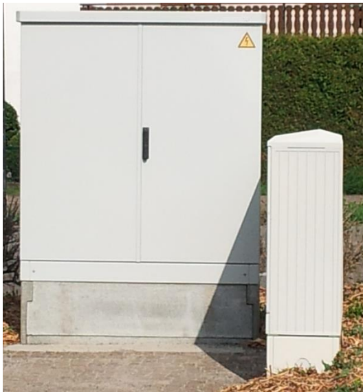
Abbildung 8.7: Abbild (links, 250 kVA) und Abmessungen (rechts) eines Strangreglers
