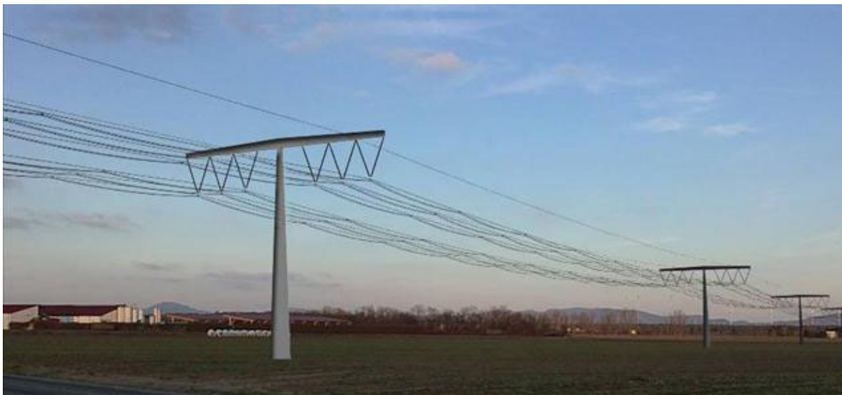
Bild 1 Visualisierung „Raumoptimierte Freileitung“ (Quelle: SAG GmbH)
