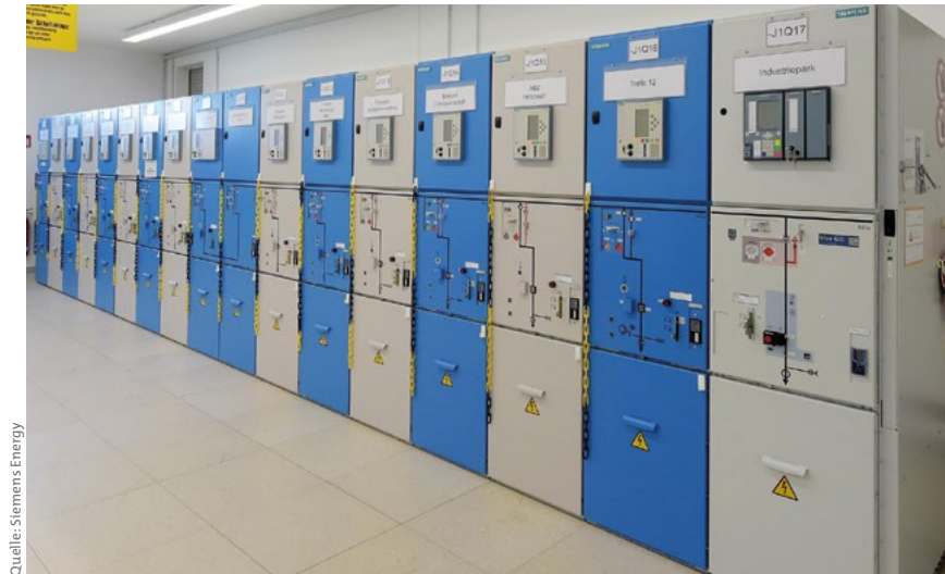
Bild 2. Siemens-Mittelspannungsschaltanlage NXPLUS C 24 bei der Westnetz GmbH, Umspannanlage Bekond
