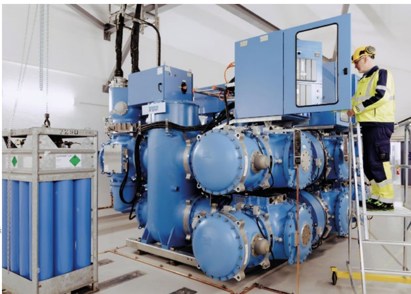
Bild 1. 145-kV-GIS mit Clean-Air-Isolation und Vakuumleistungsschalter von Siemens Energy
