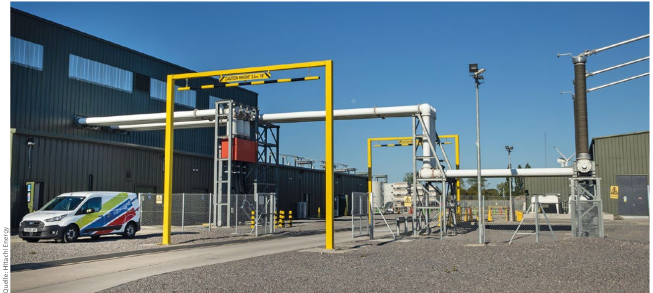
Bild 4. Retrofill der 420-kV-Bestandsanlage »Richborough«, NG UK
