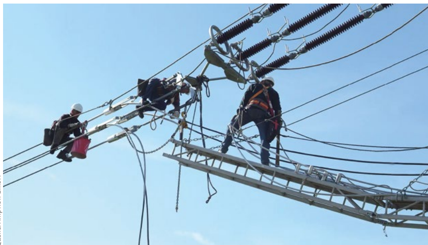
Bild 1. Einziehen von Freileitungsseilen
